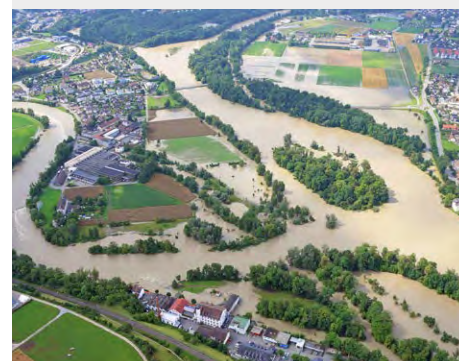
Im Wasserschloss bei Brugg (AG) münden die Nebenflüsse Reuss und Limmat in die Aare. Im Juli 2021 kam es auch hier zu Ausuferungen, doch blieb das Siedlungsgebiet dank den getroffenen Schutzmassnahmen weitgehend verschont.
