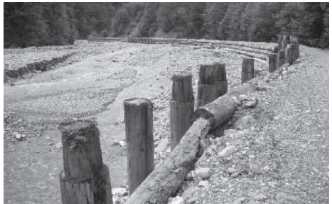
Schraubach, Gebiet «Ravinis», Sicht flussabwärts. Oberes Bild: Zustand Ende Juli 2005. Links der Bach, in der Bildmitte Holzpalisaden (senkrecht) und Kastenwand (horizontal); rechts die Fahrpiste. Im unteren Bild die gleiche Lokalität nach dem Unwetter vom 22./23. August 2005: Der Schraubach hat die künstlichen Bewehrungen zerstört und sein Flussbett auf die ursprüngliche Breite erweitert.
