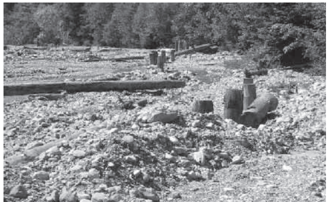
Schraubach, Gebiet «Ravinis», Sicht flussabwärts. Oberes Bild: Zustand Ende Juli 2005. Links der Bach, in der Bildmitte Holzpalisaden (senkrecht) und Kastenwand (horizontal); rechts die Fahrpiste. Im unteren Bild die gleiche Lokalität nach dem Unwetter vom 22./23. August 2005: Der Schraubach hat die künstlichen Bewehrungen zerstört und sein Flussbett auf die ursprüngliche Breite erweitert.
